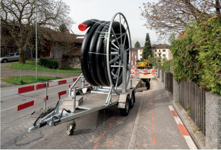
An der Goldiwilstrasse werden erstmals flexible Wärmerohre verlegt. Diese innovative Technik ist effizient, kostengünstig und nachhaltig.
