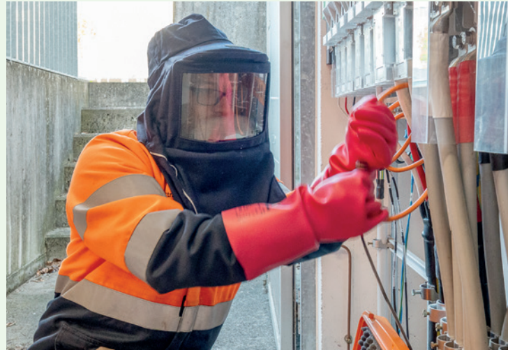
Für den Ausbau einer Einstellhalle mit Ladeinfrastruktur für Elektromobilität werden präzise Lastgangkurven erfasst. So entsteht eine fundierte Basis für eine effiziente Planung und den Betrieb.
