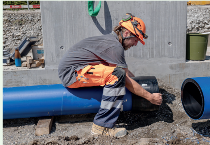
Am Gurnigelweg werden die Trinkwasser-Verbindungsleitungen ersetzt. Bei den Bauarbeiten ist immer wieder auch Muskelkraft gefragt.
