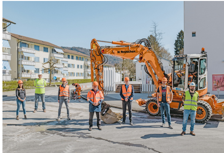
Im Bereich Schlehdornweg, KirCHFeldstrasse und Turmstrasse wurden die Quartierserschliessungen gebaut.
