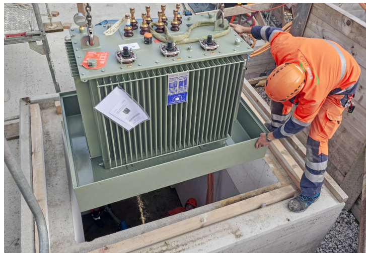
Einbau von zwei Verteil-Transformatoren mit je 630 kVA Leistung im ehemaligen Gschwendareal, zur Versorgung des Trafokreises Unterdorfstrasse.
