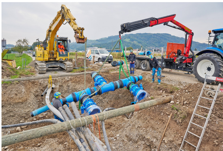
Die entscheidende Phase beim Neu- und Ersatzbau der Transportleitungen beim Grundwasserpumpwerk Burgergut, zur Erhöhung der Trinkwasser-Versorgungssicherheit in Steffisburg.
