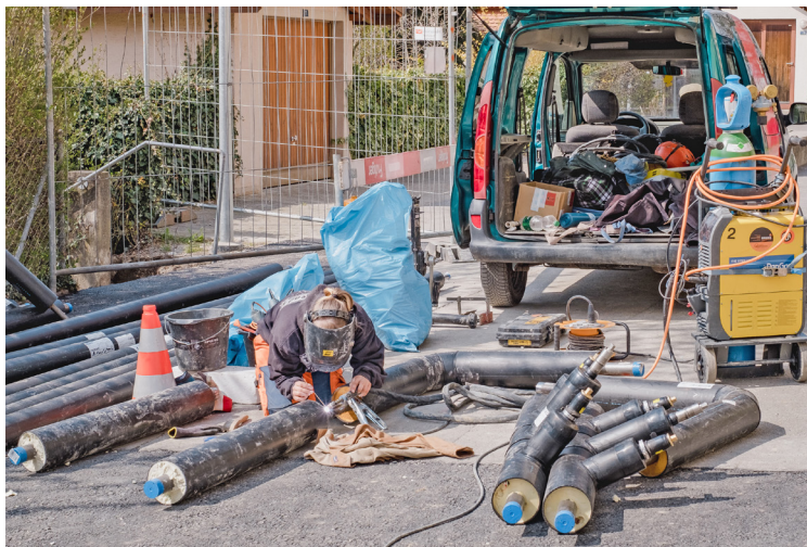
Die Erschliessung des Schulhauses Kirchbühl, des Quartiers Höheweg/Narzissenweg, der Villa Schüpbach und des Gschwendareals wurden abgeschlossen.
